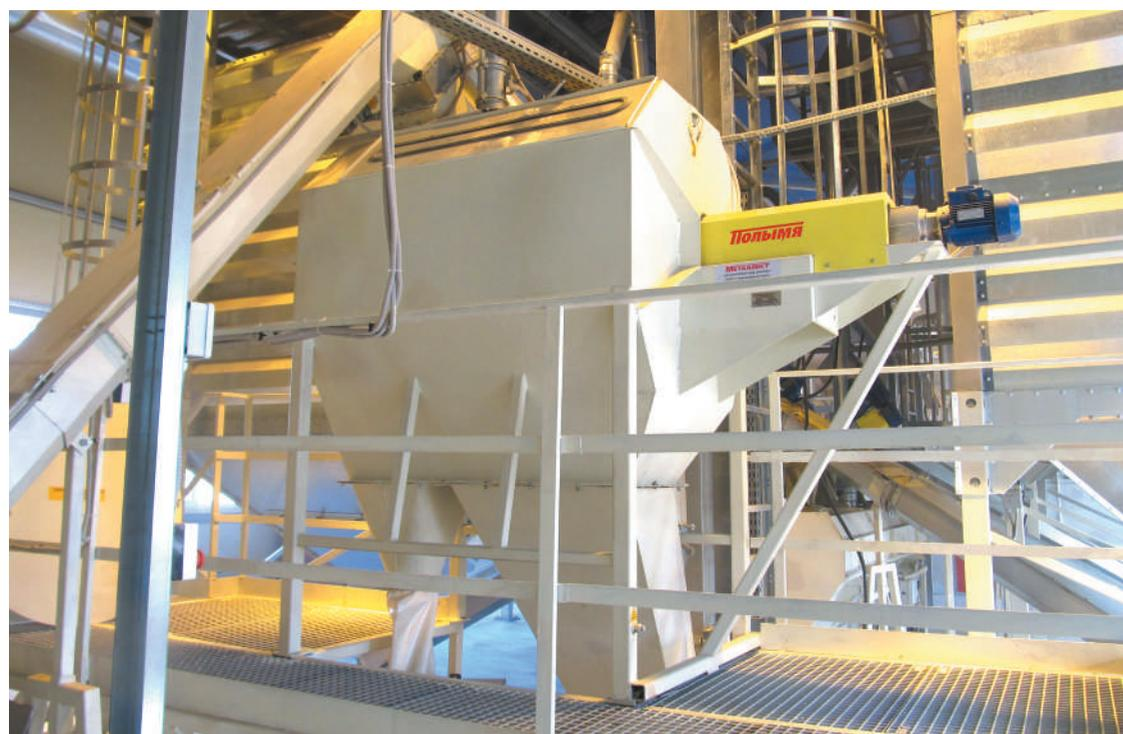
Скальператор предназначен для очистки сырья, поступающего на линии по приготовлению комбикормов, от посторонних предметов (камней, стеблей растений и др.), попавших в зерно во время его уборки, хранения и транспортировки.
